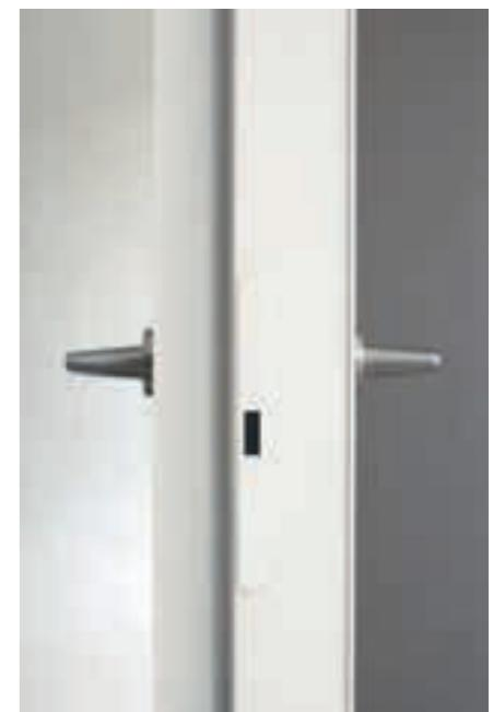
Il pannello, spesso quanto il muro, quando chiuso diventa a filo del muro da entrambi i lati.
