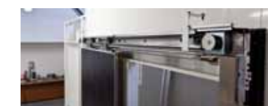
1. Binario di scorrimento manuale 1. Manual sliding rail
